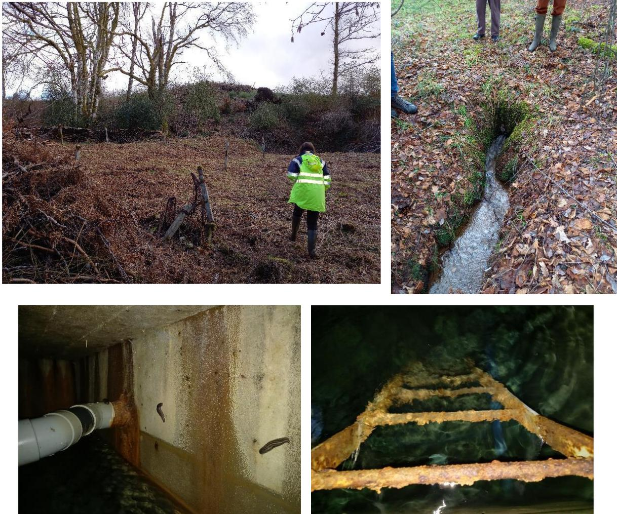
**Figure 5.** Etat de la zone de captage et du regard de captage de « Les Fayes ». En haut à gauche : zone du champ captant ; en haut à droite : exutoire du trop-plein ; en bas à gauche : intérieur de la bache (présence de zone d'infiltrations potentielles et de mollusques ; en bas à droite : échelle rouillée à supprimer.
